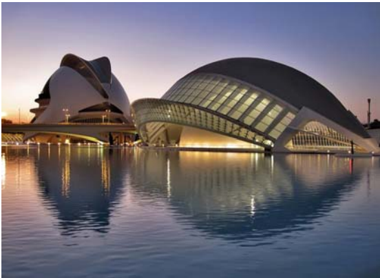
Công trình xây dựng tại khu đô thị nghệ thuật và khoa học thành phố Valencia (Tây Ban Nha)
